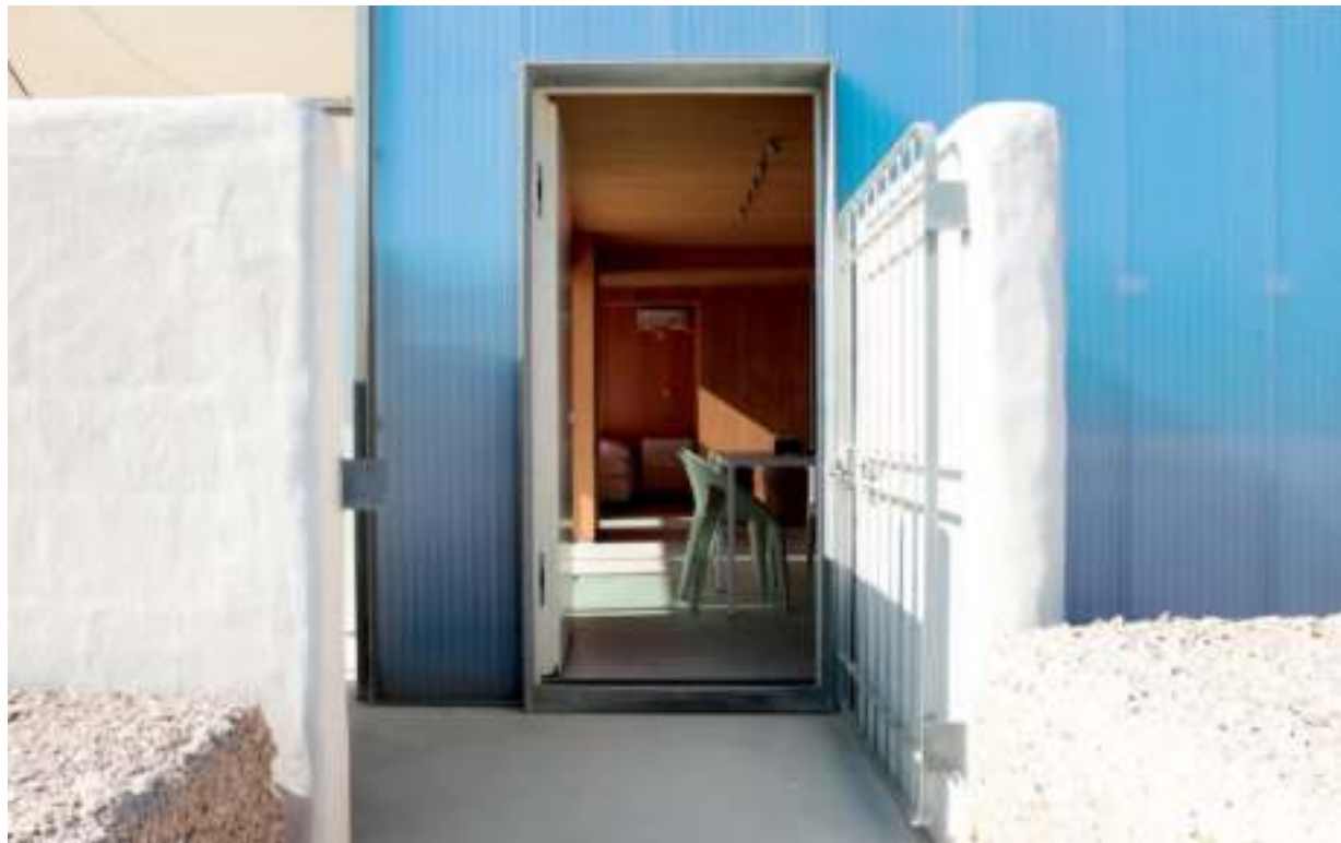
Veduta della veranda sul mare, prospetto est Ingresso al capanno dalla parete in policarbonato, prospetto nord
