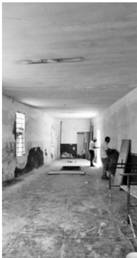
←↓ Lo spazio prima dell'intervento di recupero
