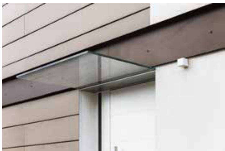
↑ ↗ Dettagli della parete ventilata in lastre di cotto
