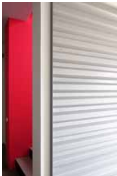
→ In sequenza il rivestimento in lamiera grecata microforata e il volume rosso tra le due rampe delle scale
