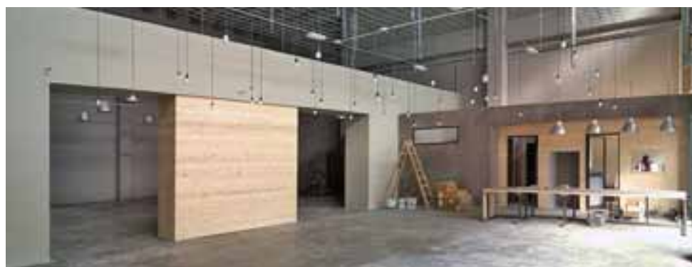
↑ Parete contenitore e blocco servizi in fase di completamento
