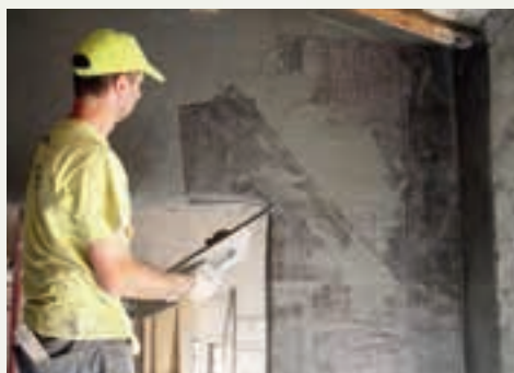
Rinforzo strutturale costituito da rete bidirezionale in fibra di carbonio e legante idraulico pozzolano
