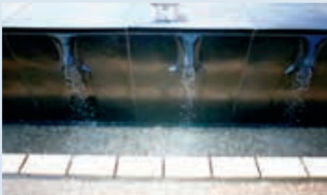
Dettaglio vasca d'acqua
