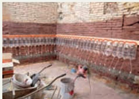
Barriere chimiche, efficaci contro la risalita dell'acqua per capillarità
