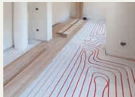
Sistema Zeromax Eurotherm con massetto e gessofibra
