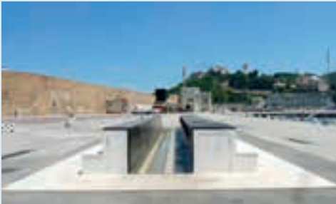
Veduta laterale della fontana
