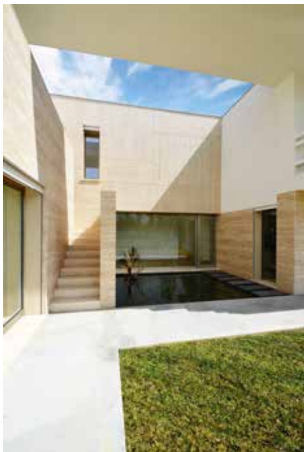
↓ Vista del patio centrale e scala di accesso al terrazzo del piano primo
