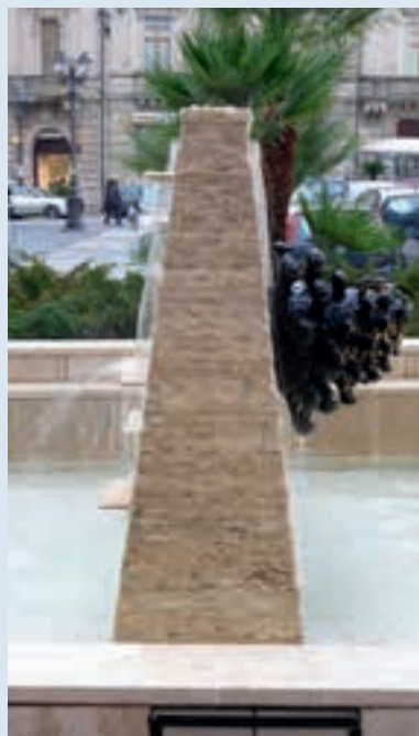
Veduta laterale parete in travertino
