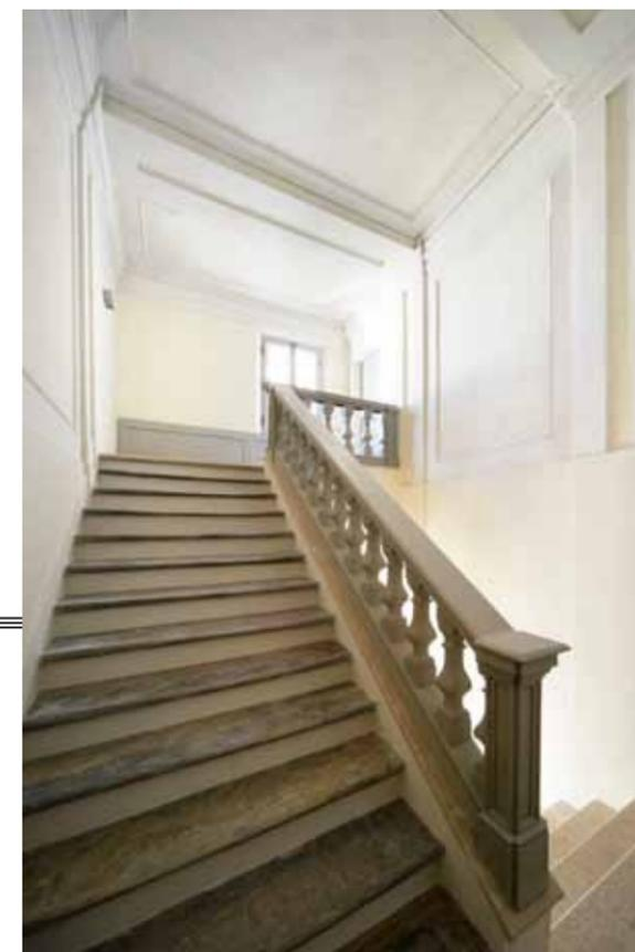
↳ Uno degli accessi alle unità immobiliari visto dalla corte interna. La pavimentazione in materiale lapideo chiaro è stata utilizzata per segnalare la posizione di colonne e paraste, per incorniciare pianerottoli ed evidenziare gradini ed ingressi. Quella in cotto, montato a 45°, è stata utilizzata per saturare le superfici intermedie e interne alle cornici.
